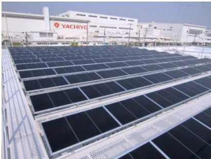
福利厚生棟の屋根へ、ホンダソルテック製太陽光パネルを120枚設置
