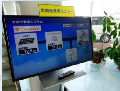
発電の状況は、福利厚生棟の玄関口に設置した大型モニターで常時把握
