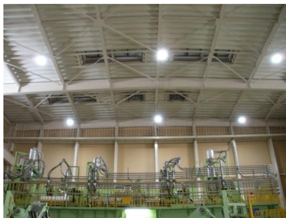
樹脂製燃料タンク工場
